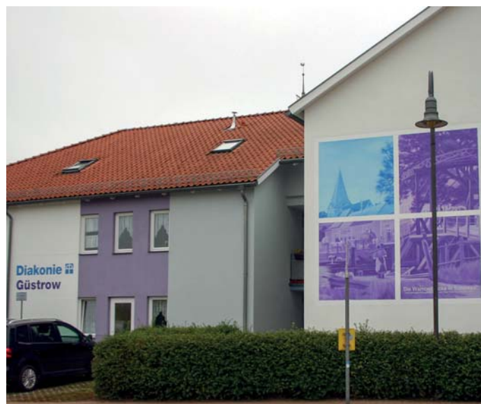
Die Fassade des Betreuten Wohnens in Schwaan nach Beendigung der Arbeiten.
