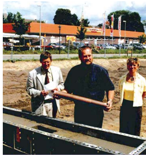
Grundsteinlegung zum Neubau des Betreuten Wohnens in Bad Sülze.
